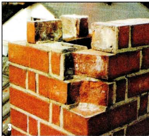
Удалив с кирпичей старый раствор, можно приступить к восстановлению кладки.
