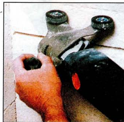
Пазы в кладке вплоть до самого угла можно выбрать и с помощью насадки-долота, приводимого в действие электродрелью.
