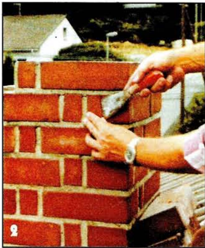
Треснувшие и отслоившиеся кирпичи вынимают из кладки, поддевая их шпателем.
