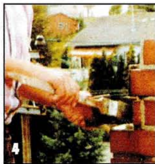
Подлежащие ремонту места обильно смачивают водой. Промазав поверхности цементным молочком, начинают кладку кирпичей на растворе.
