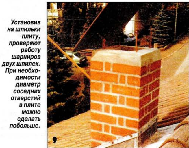
Уложив на шпильки плиту «крыши», на ней размечают и сверлят отверстия под шпильки.
