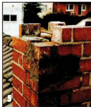
Излишки слегка схватившегося раствора удаляют увлажненной губкой.
