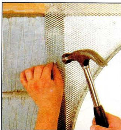
Прибивают секции арки к стене гвоздями. Сетка должна перекрыть притолку до штукатурки.
