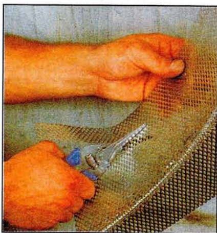
Разложив секции арки и разметив на них толщину стены, раскраивают детали по ширине.
