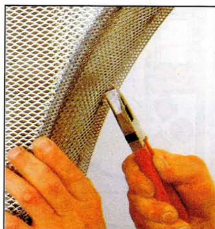
Секции арки скрепляют пропущенной через сетку оцинкованной проволокой.
