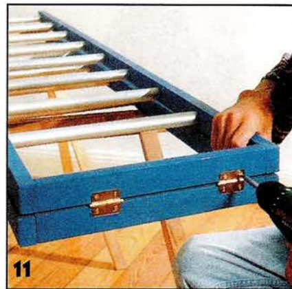
11 Рамы обеих «лестниц» соединяют на двух петлях, позволяющих изменять их положение относительно друг друга.
