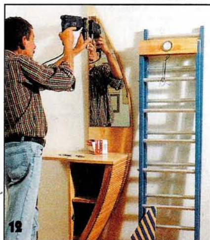
12 Размечают положение вешалки на стене и сверлят отверстия под дюбели для её крепления.
