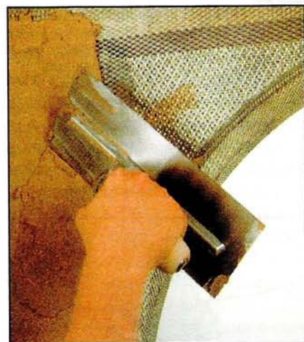
Сначала сетчатую арку покрывают слоем штукатурки, имеющей хорошую адгезию к металлу.
