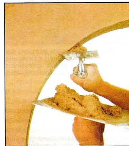
Оштукатуривают арку окончательно и затирают её фасадные поверхности заподлицо с поверхностями стен.
